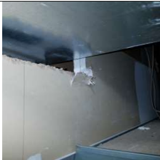
New gypsum double layer
